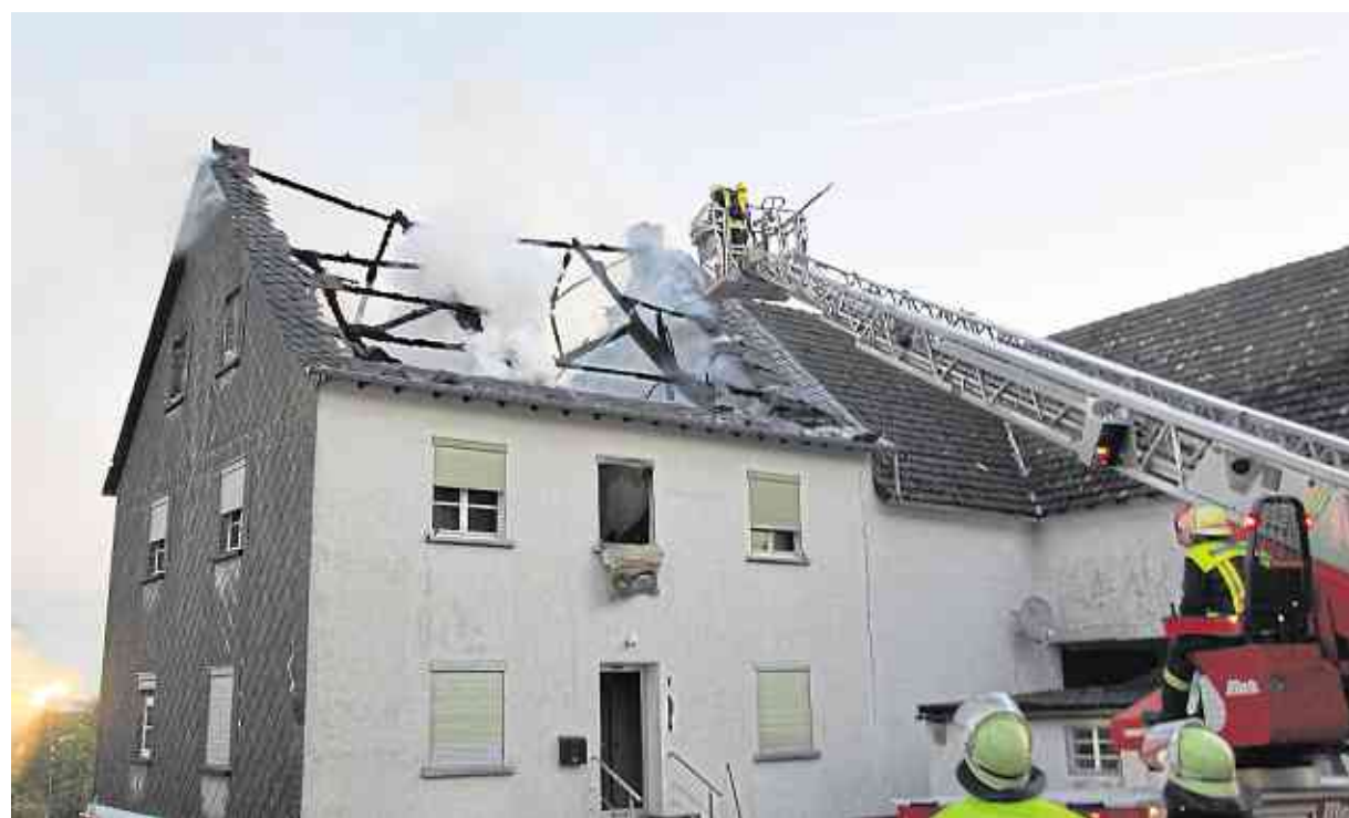
Komplett abgebrannt ist der Dachstuhl eines Wohnhauses in Zilshausen: Etwa 80 Feuerwehrleute aus der Verbandsgemeinde Kastellaun waren im Einsatz. In der Scheune wurde eine Cannabisplantage entdeckt. Foto: Nikolay
